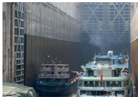
Die Schiffe im Inneren des Hebewerks über- winden 113 m Höhe in einer Stunde. Der Antrieb des Schiff- troges erfolgt über vier Zahnräder, die an einer 113 m hohen Zahn- stange laufen.
